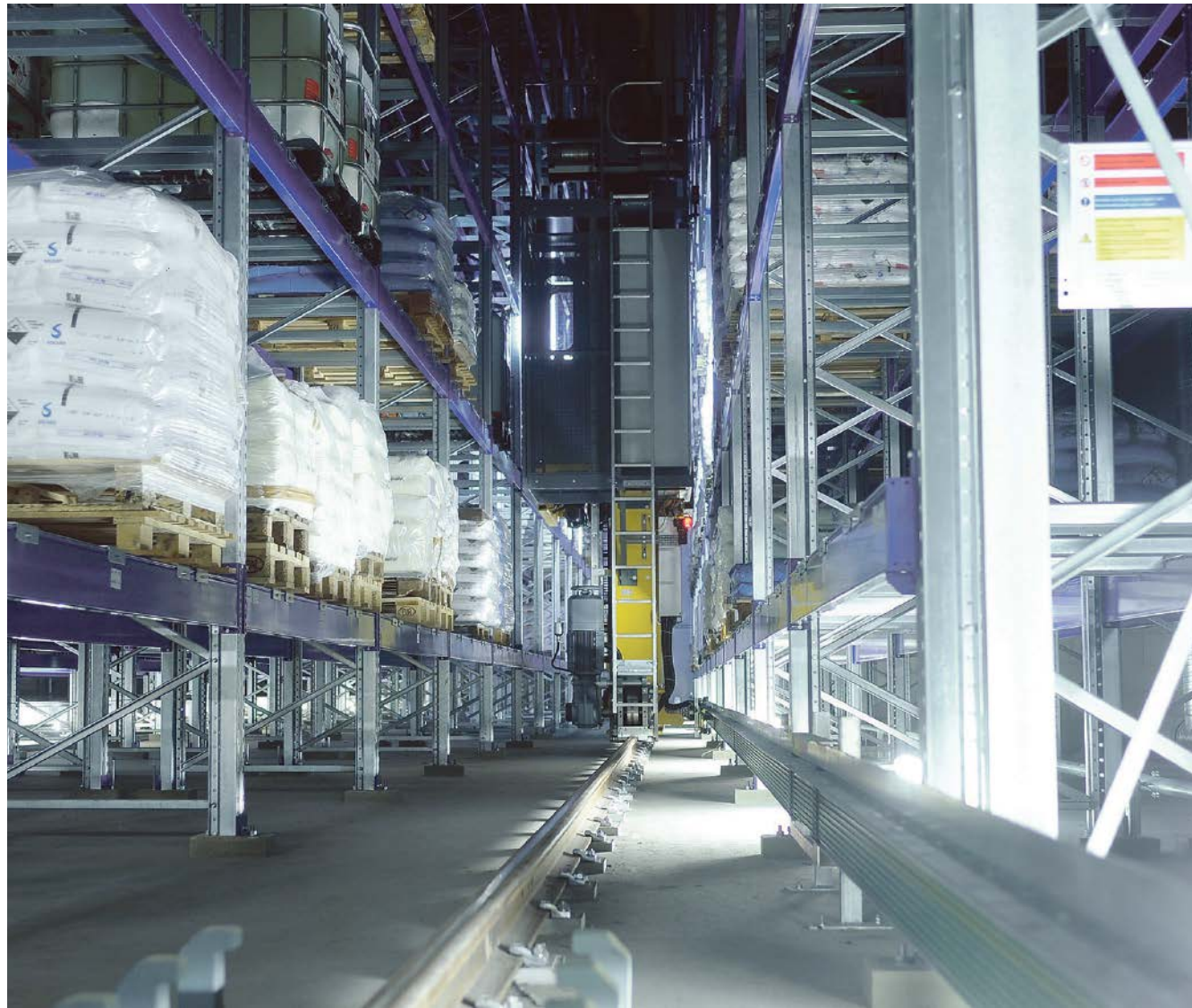
Am Standort Marbach am Neckar konzentriert sich Häffner vorrangig auf die Lagerung von abgefüllten sowie zugekauften Waren.
