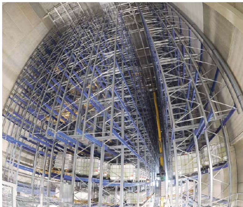
Das vollautomatische Hochregallager in Marbach am Neckar verfügt über eine große Anzahl von Tanks für Lösemittel, Säuren und Laugen und rund 7.000 Palettenstellplätze.
