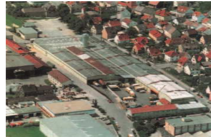
Die Firma Häffner aus der Vogelperspektive. Hier werden feste, flüssige und gasförmige Chemikalien umgeschlagen und gelagert.
